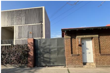
Adosamiento de edificación continua de 3 pisos
