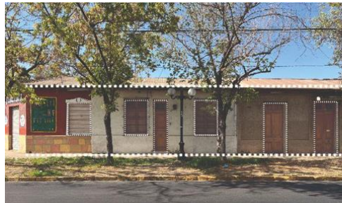
Composición de la fachada y altura del primer piso
